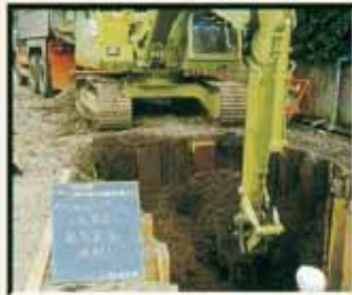
① 機械掘削
