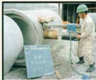
④ 削孔状況
