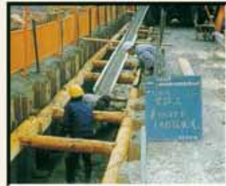
③ 基礎コンクリート投入
