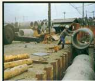
⑤ 台付管吊り込み
