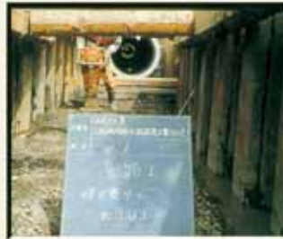
② 基礎碎石転圧
