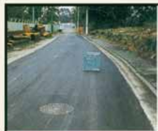
⑫ 舗装工完了
