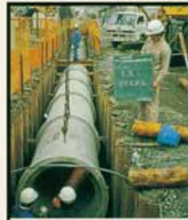
⑥ 台付管布設据付け
