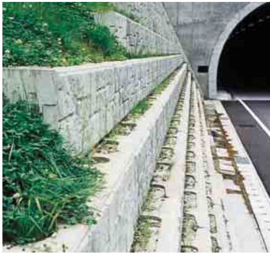
清内路トンネル
