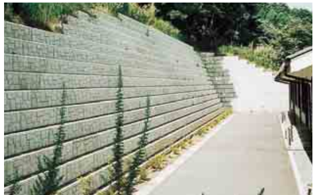
布施浄化センター 望月町役場
