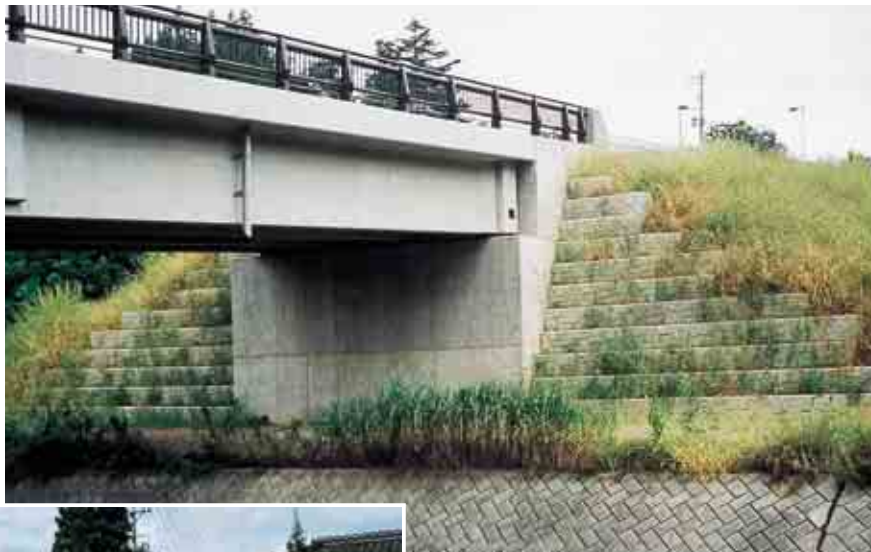
別所線橋梁下部工事
