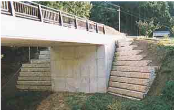
小舟橋橋梁取り付け工事 生坂村役場
