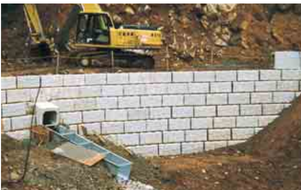
国補宮川総合開発事業付け替え道路改良工事1工区 筑北ダム建設事務所
