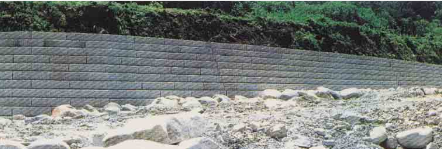
上松町小川地籍 県単道路改良工事
