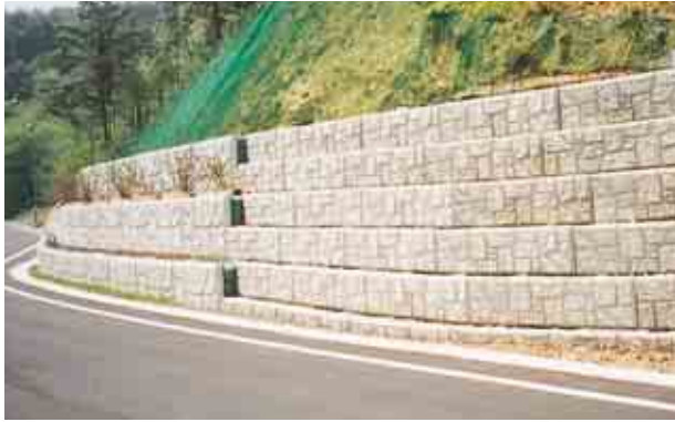
急傾斜崩落防止工事 長門町役場
