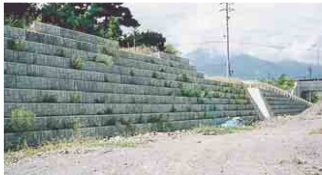
国補道路改良工事 松本～豊科（高家バイパス）
