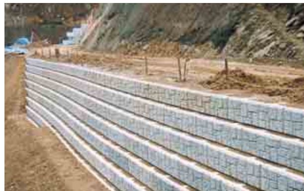
国補宮川総合開発事業付け替え道路改良工事2工区 筑北ダム建設事務所
