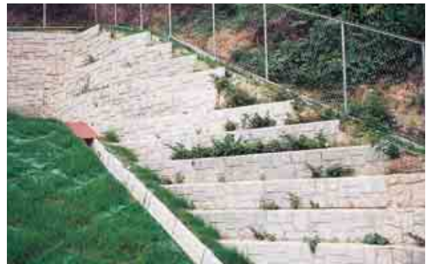
三穂浄水場施設工事 飯田市役所水道課
