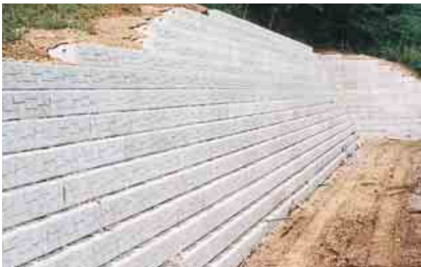
処理場造成工事 望月町役場
