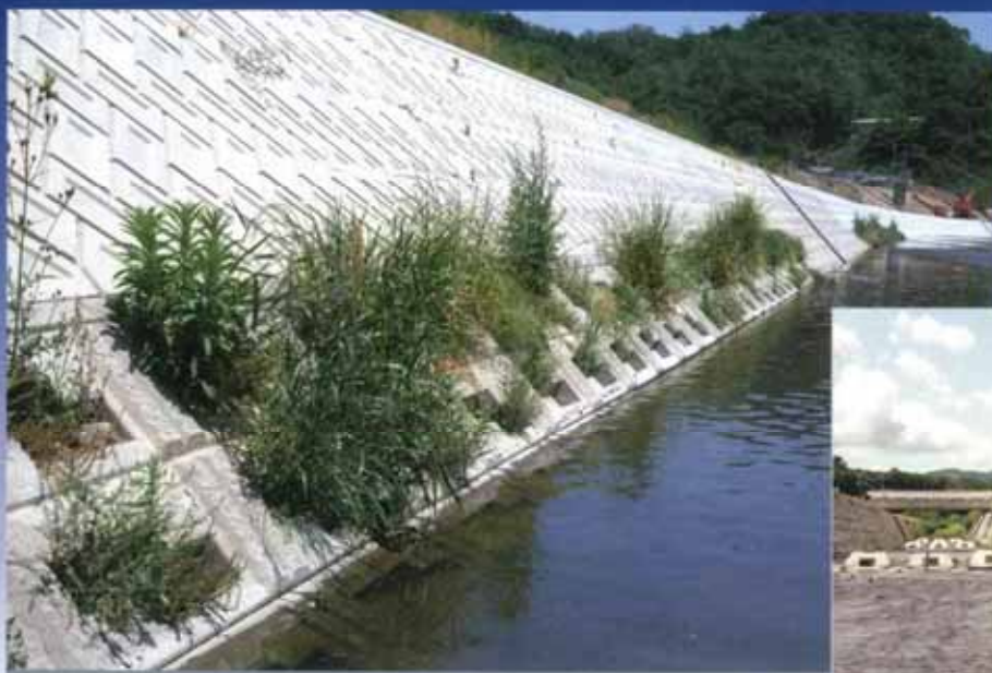
岡山県井笠地方振興局 小田川公共河川改修工事 施工後約1年経過
