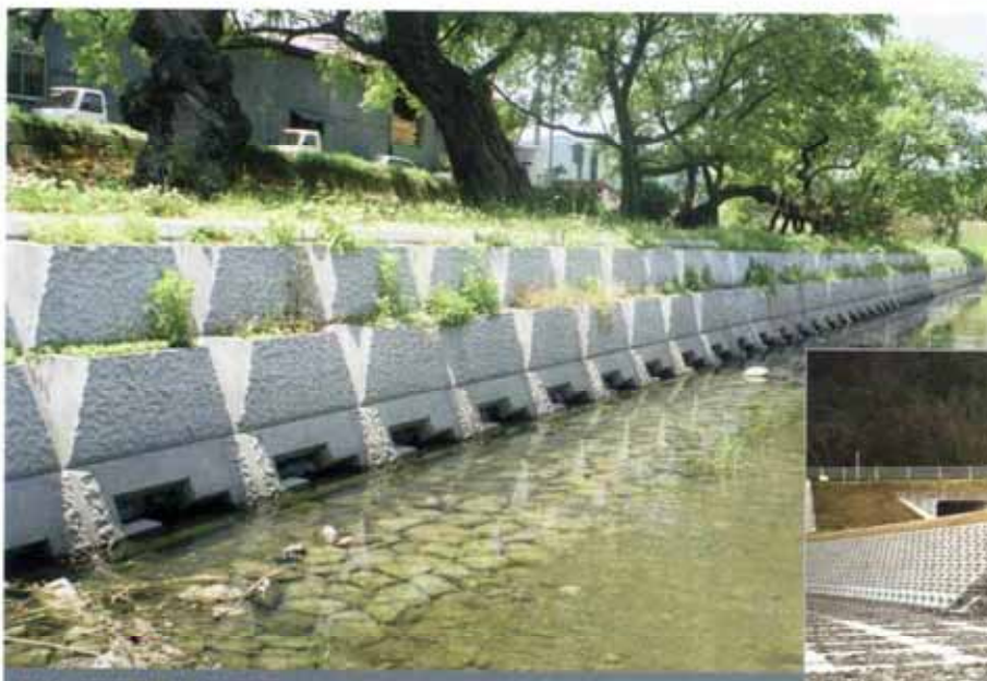
岡山県真庭地方振興局 備中川改修工事
