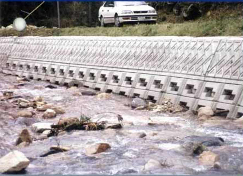
岡山県栗津町役場 河川改修工事
