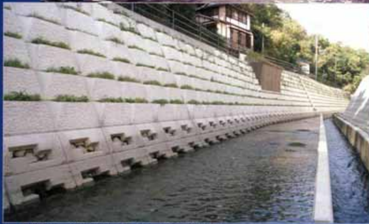
緑草ブロック及び鳥類営巣ブロックとの併用施工
